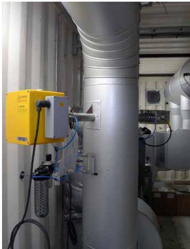
*На каждом анализируемом участке луч испускается от источника к приемнику. Затем по оптоволоконному кабелю сигнал передается на систему обработки данных*
